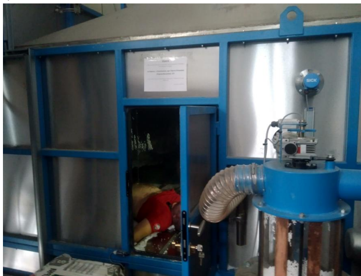
Рис. 1. Вхід до сушарні цеху.
